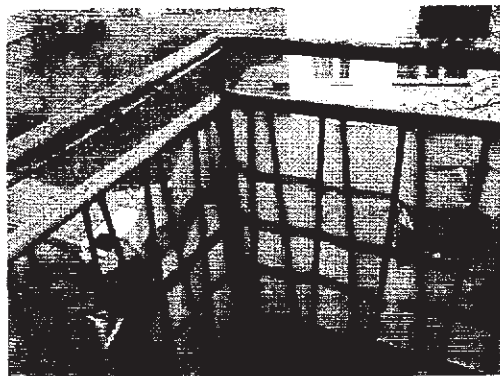
Zdjęcie Nr 4 Wypełnienie balustrady prętami
