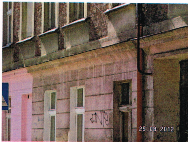
Fot. 11. Zły stan obróbek blacharskich gzymsu powoduje zacieki pod jego krawędzią.
