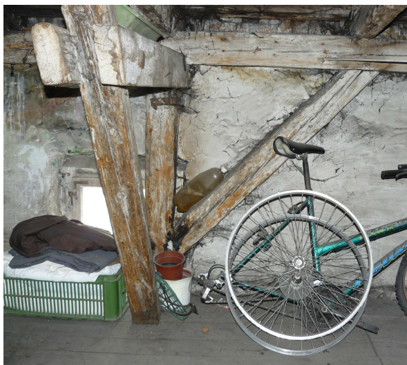
uszkodzenia słupa i miecza
