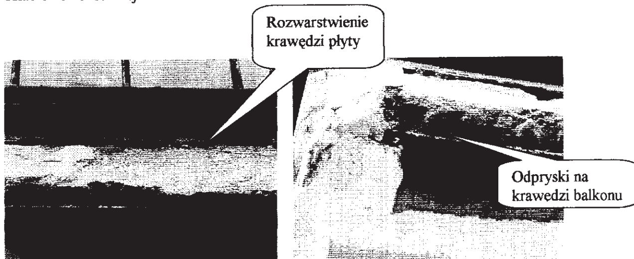
Zdjęcie Nr 5 Rozwarstwienie płyty balkonu, uszkodzony narożnik.
