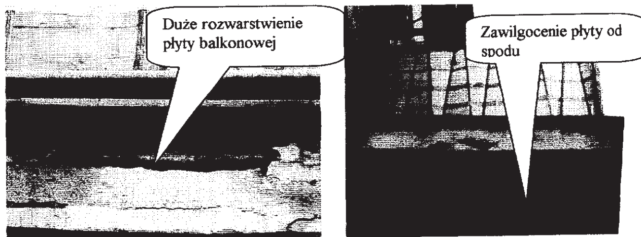
Zdjęcie Nr 8 Uszkodzenie płyty balkonowej.
