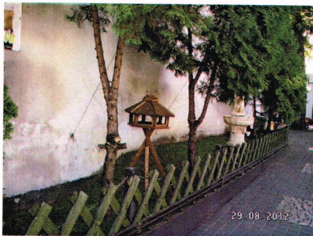
Fot. 1. Ziemia nadsypana przy ścianie szczytowej podnosząca lokalnie poziom gruntu powyżej posadzki parteru.
