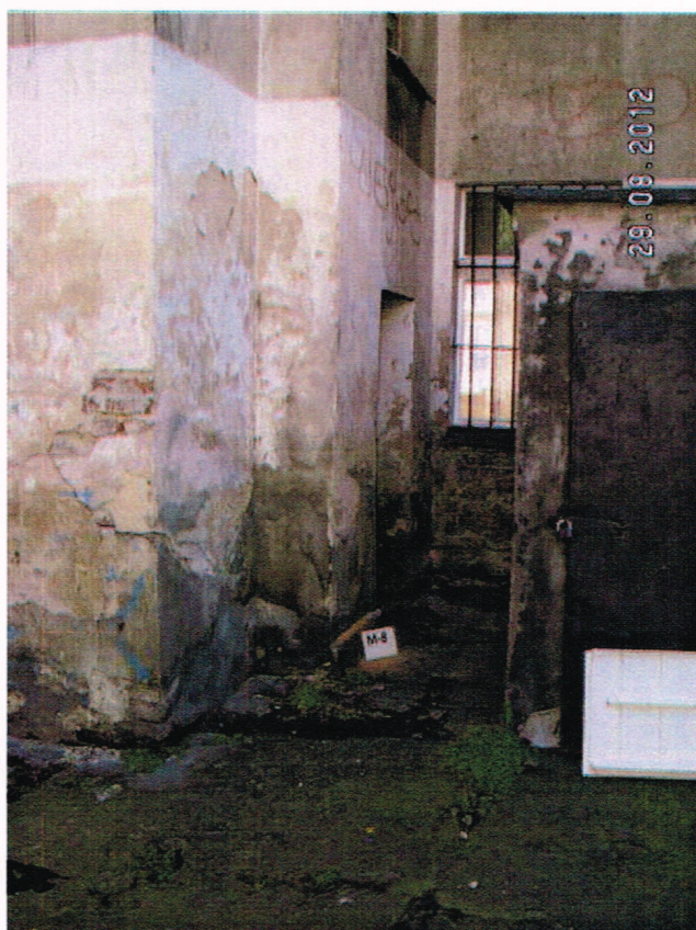
Fot. 7. Miejsce pomiaru zawilgocenia M8.
